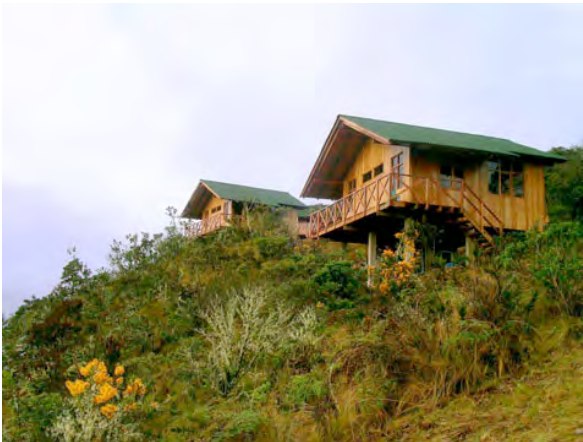
Las cabañas recién construidas en la Estación Biológica Wayqecha.
